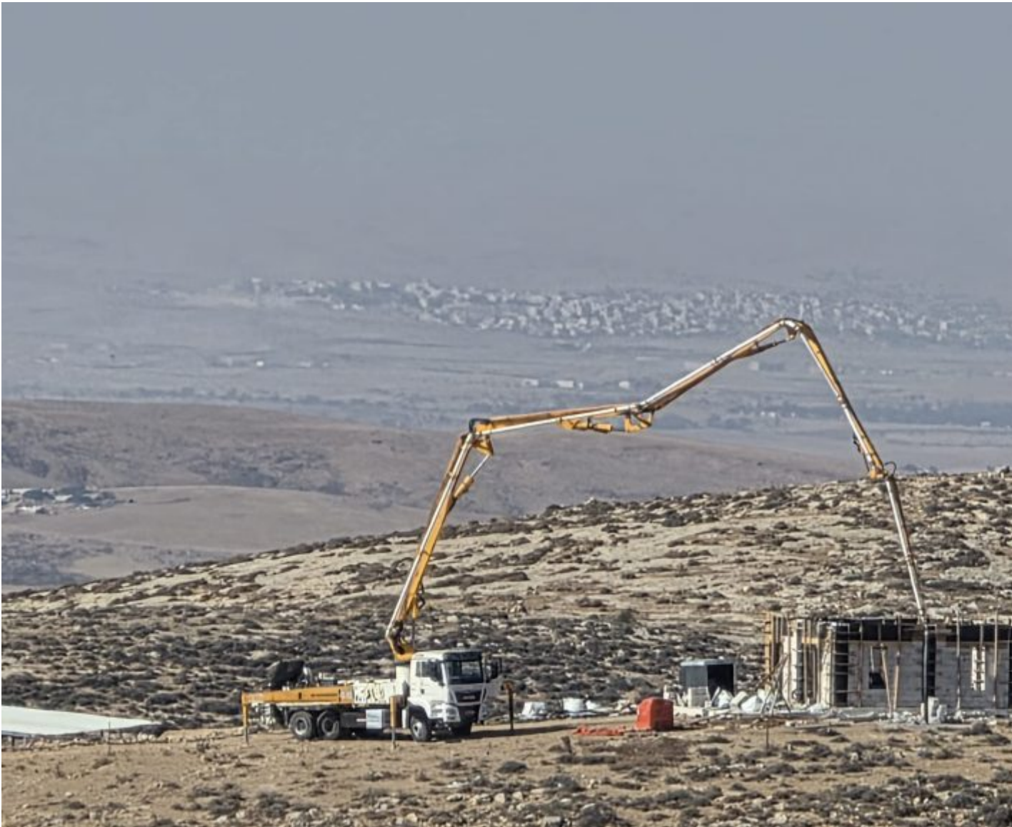
On coule du béton lors de travaux de construction dans un avant-poste israélien implanté sur les terres du village palestinien de Tabaqat al-Jundi, au sein de la zone de tir 918, dans le sud de la Cisjordanie, le 4 août 2025. (Jaber Dababseh)
